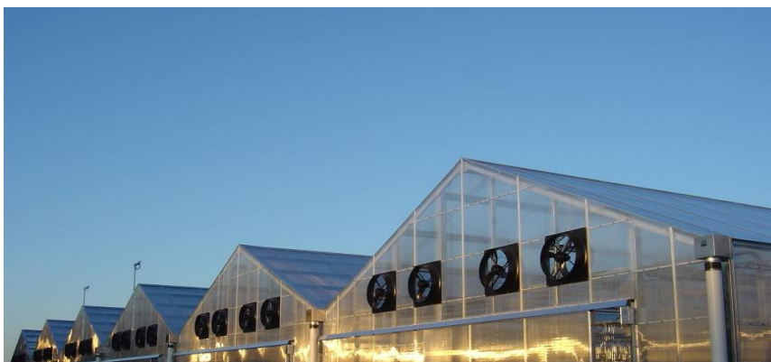
Figura 4. Vista externa do secador solar THERMO-SYSTEM Solar Dryer. Fonte: PARKSON, 2016.
