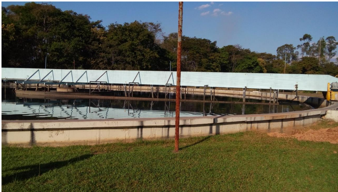
Figura 14. Decantador primário em funcionamento.
