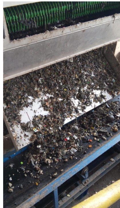
(d) Resíduos retirados do gradeamento fino.
