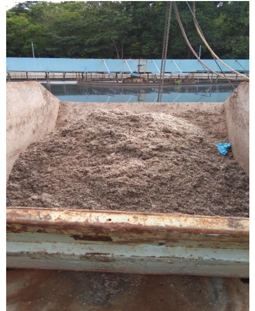
(b) Resíduo flutuante retirado pelos varredores giratórios do decantador primário.
