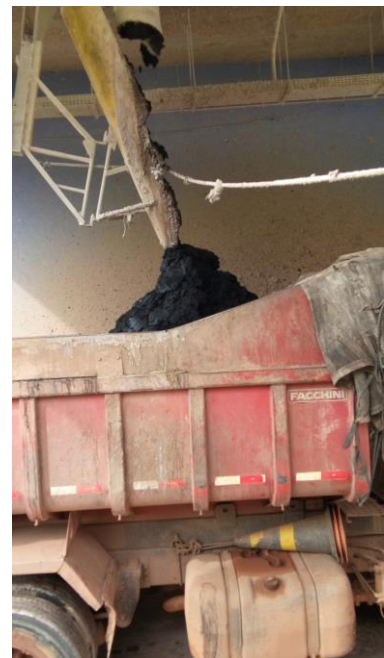
(d) Detalhe do carregamento do lodo após o tratamento (cal).
