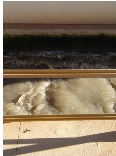
(b) Imagem do esgoto bruto que chega na ETE Goiânia.
